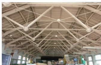
屋根の構造(南から)
