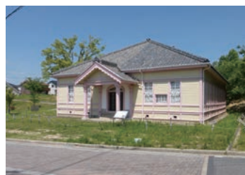
講堂外観(西から)
