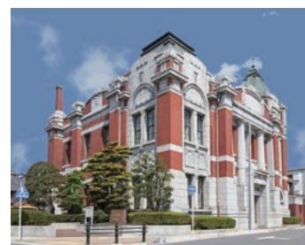
建物全景(南西から)
