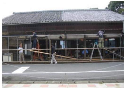
2008年9月 東側下屋の撤去
