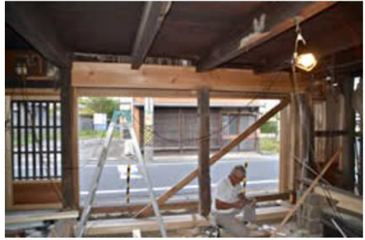
2014年9月 玄関入口の敷鴨居取付
