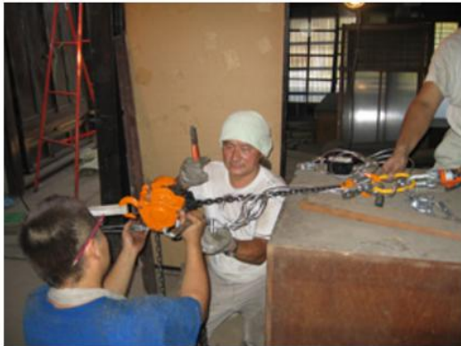
2005年9月 屋起こし（柱を垂直に修正）
