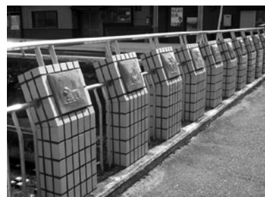
【橋の欄干にある干支の陶板】
