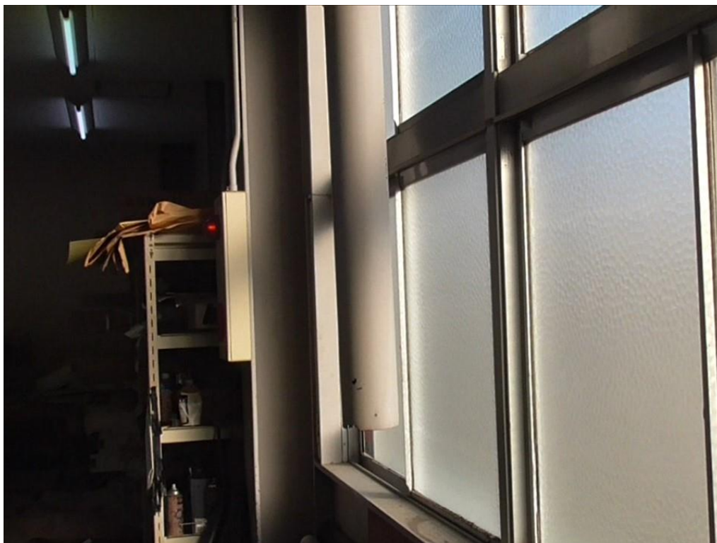
1階の印刷部に残された連絡管。昔は滑車がついていて、刷り上げた記事を2階に送ることができました。
