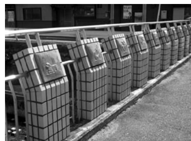
【橋の欄干にある干支の陶板】
