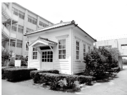
全景（北東から）
