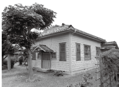
局舎（南西から）
